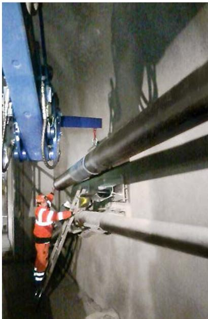
Fig. 12 Montage der duktilen Gussrohre mit Kleinbagger im Schrägstollen
