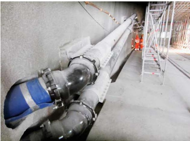
Fig. 7 Wanddurchführung durch Stollengewölbe mit Fixpunktconsolen im Eingangsstollen Tierfeld
