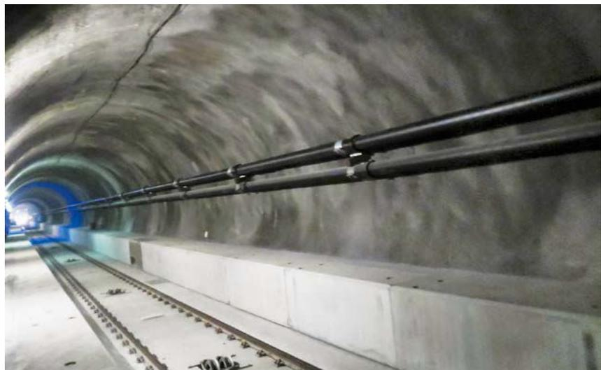
Fig. 5 Fertig montierte Druckleitungen im Schrägstollen (mit Gleitkonsolen)
